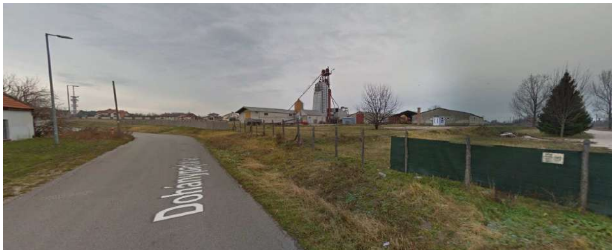
Volt TSZ-major területe a Dohányipajta utca felől (Google utcakép)
