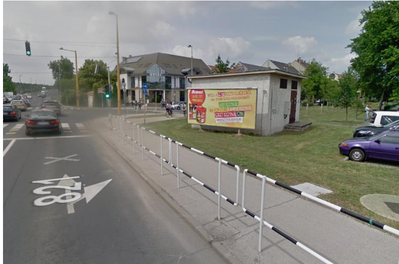
A meglévő trafóház áthelyezésre kerül
