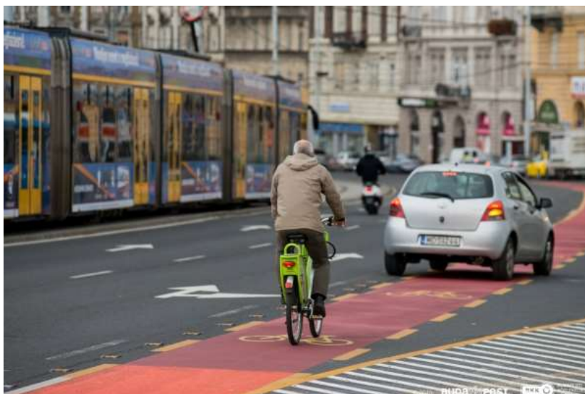
96. ábra: Kerékpársáv színezett aszfalttal Budapesten, forrás: BKK
