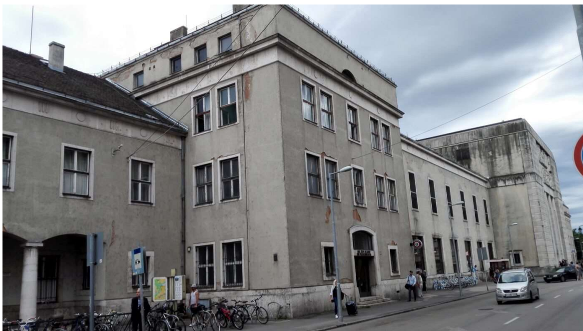
66. ábra: Kerékpártámaszok és Győr-Bike állomás a győri vasútállomáson (Fotó: infovilag.hu)
