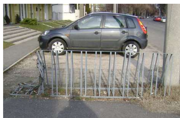
31. Rossz kialakítású és minőségű támaszok. Fotó: saját
