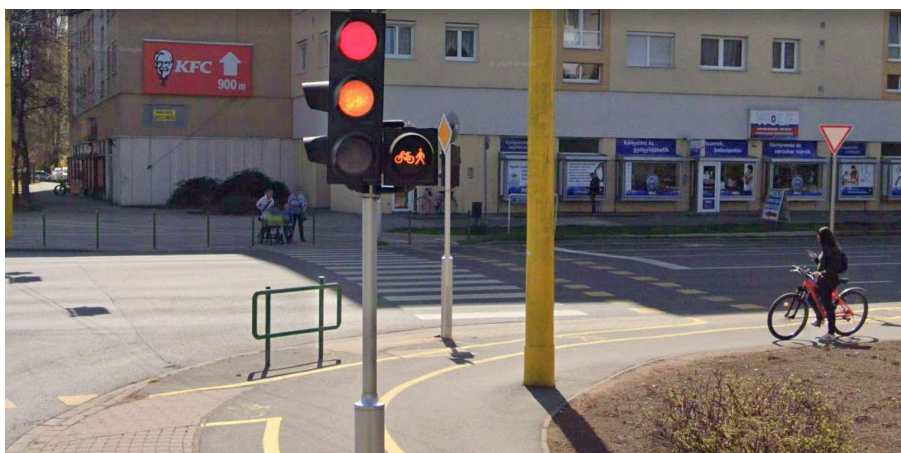
50. ábra. A Szigethy Attila utat keresztező kerékpáros átvezetés túl távol van a csomópont magjától
