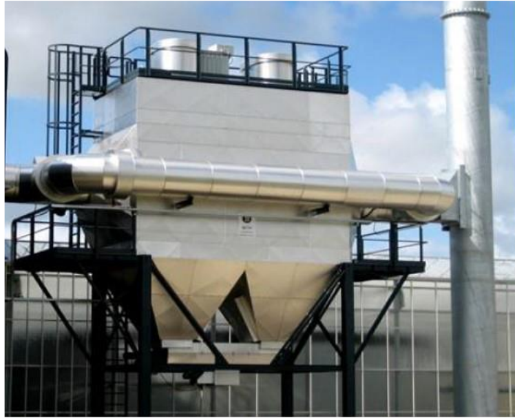
32. ábra Porleválasztó elektrofilter
