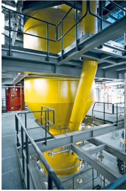
15. ábra Korszerű nyomás alatti biomassza elgázosító Skieveben [13]
