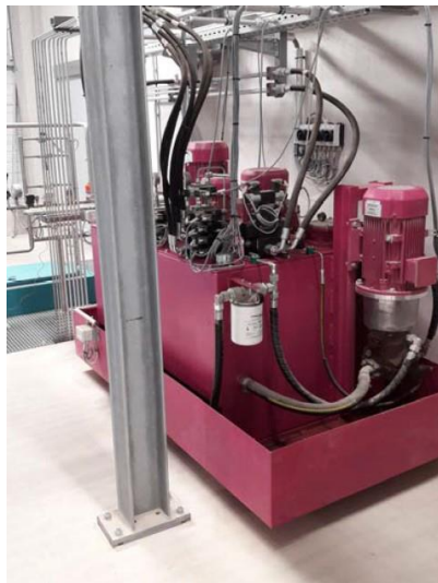
27. ábra Éklétrás tüzelőanyag továbbító hidraulikus hajtású
