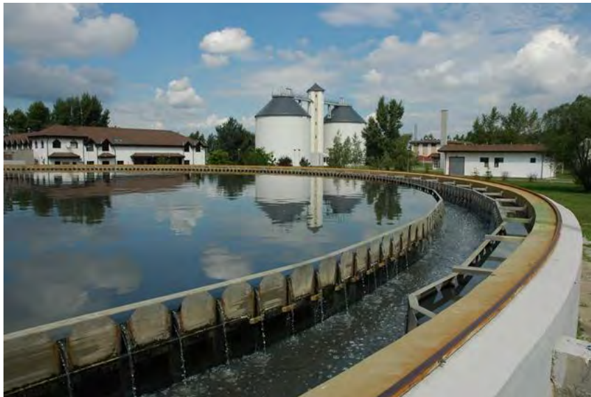
4. ábra Pannon-Víz víztározója [5]
