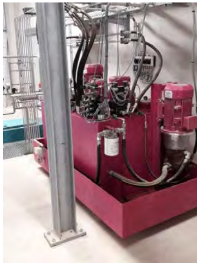
27. ábra Éklétrás tüzelőanyag továbbító hidraulikus hajtású
