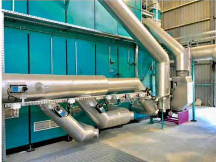
34. ábra Égési levegő bevezetések
