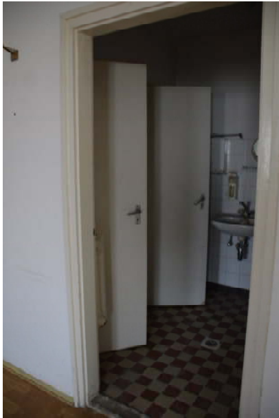
197. ábra WC-k az északi oldali helyiségből nyílóan
