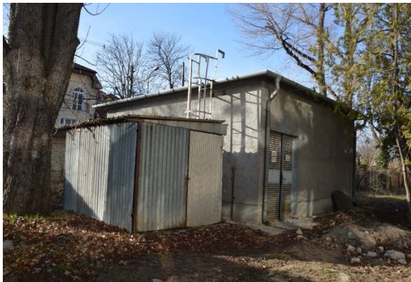
95. ábra A trafóház és a bódé DK felől tekintve
