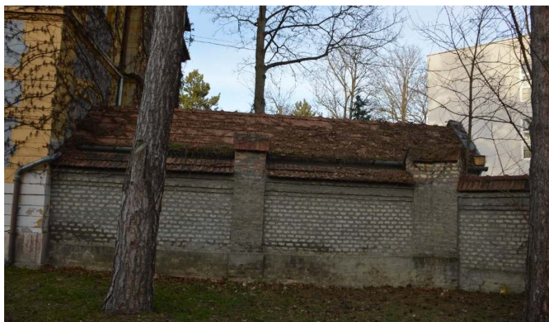
233. ábra Zrínyi utcai, nyugati homlokzat
