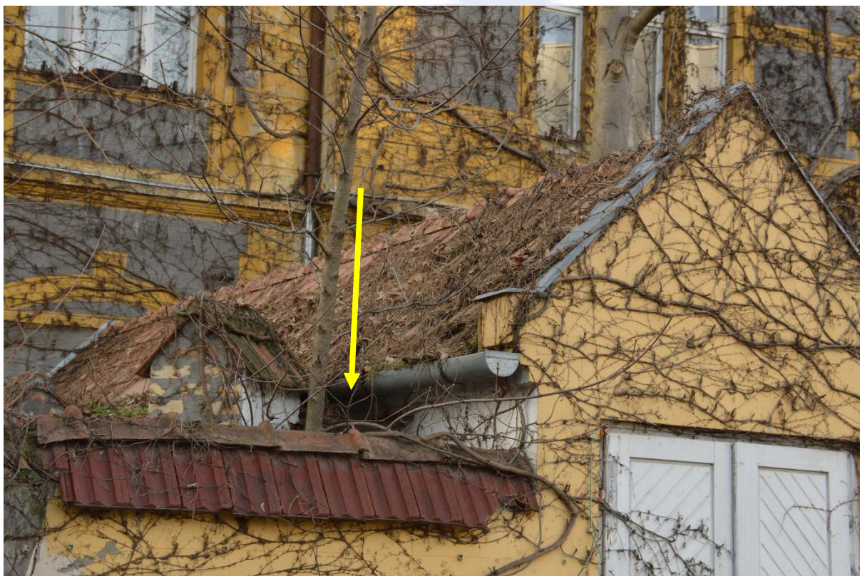
228. ábra A kerítésfal és a rámpa nyugati fala között rés van, kétszárnyú ajtó nyílik ide
