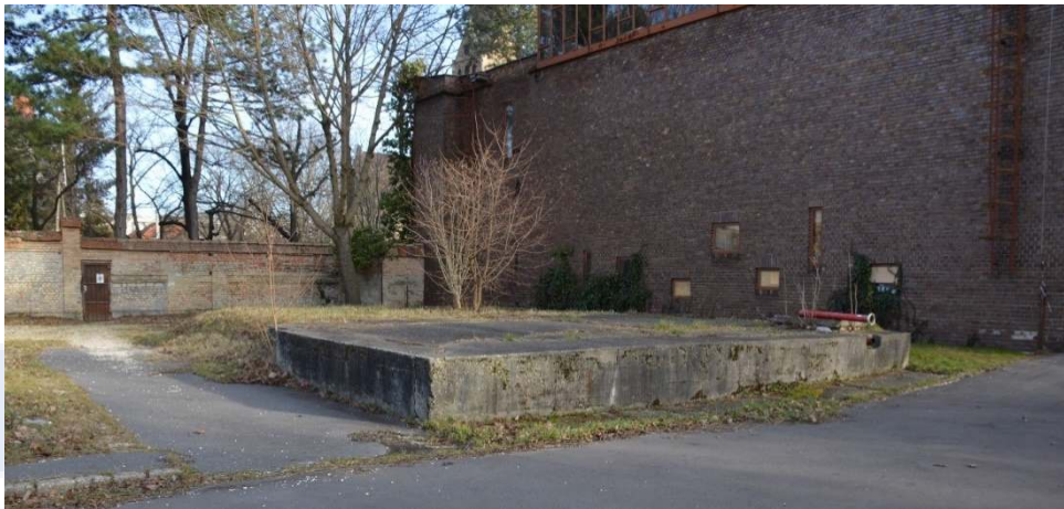
154. ábra A hidroforház maradványa, háttérben a könyvtár-klubház műemlék épülete
