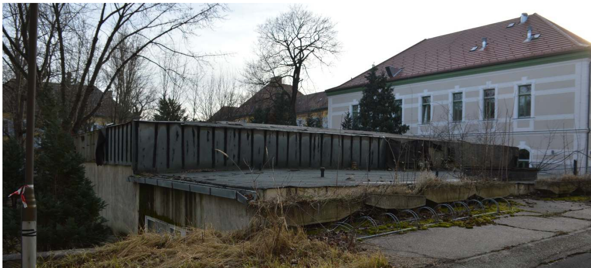
201. ábra A bunker ÉK felől tekintve
