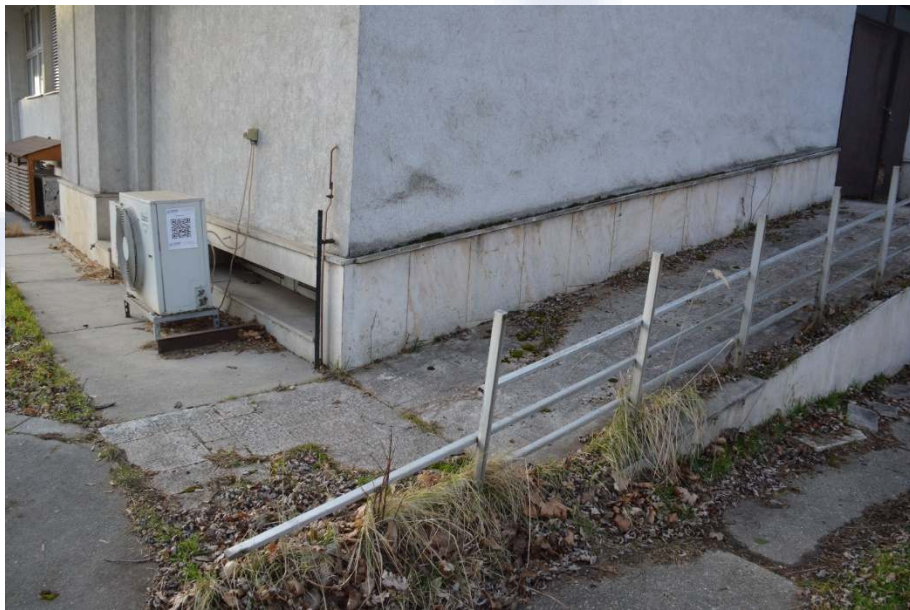
223. ábra Rámpa a keleti homlokzaton
