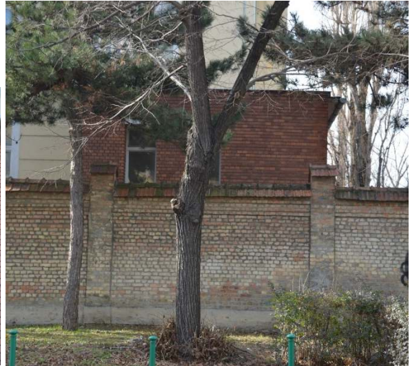
71. ábra Keleti homlokzat a Baross utca felől
