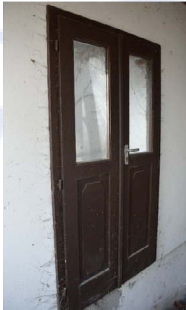
237. ábra Oldalajtó a kerítés felé
