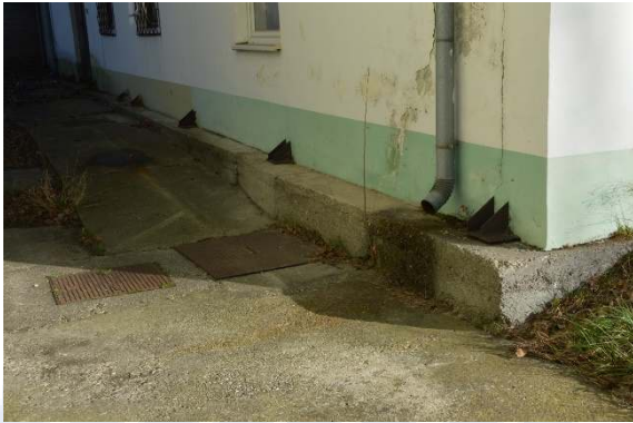
49. ábra ÉNY-i épületsarok, lábazati részlet
