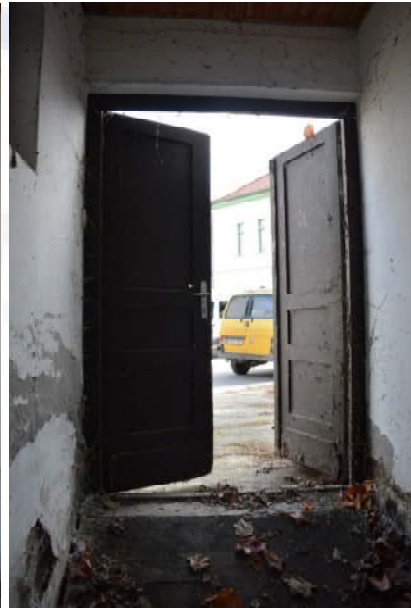
238. ábra Jelenlegi bejárat belső oldala
