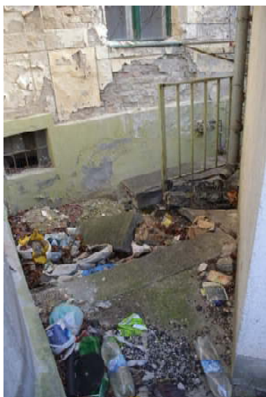
128. ábra A pincelejárati északi felől tekintve
