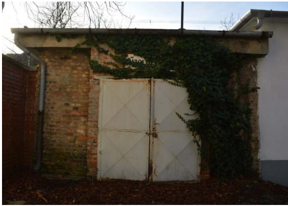
110. ábra Keleti homlokzat
