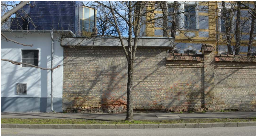
114. ábra Nyugati, utcai homlokzat, a fa mögött a befalazott ajtó helye látható
