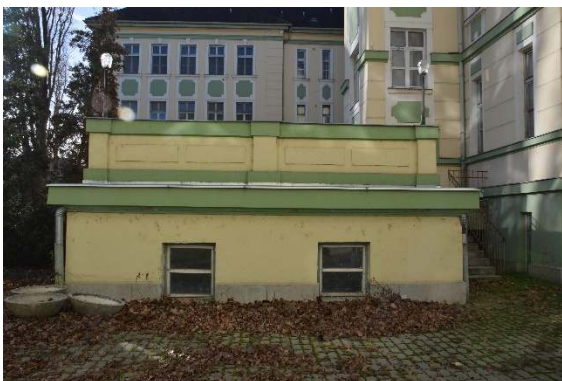
37. ábra Keleti homlokzat
