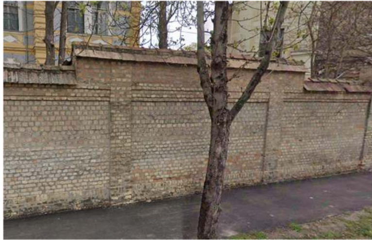
121. ábra Nyugati, Zrínyi utcai homlokzat
