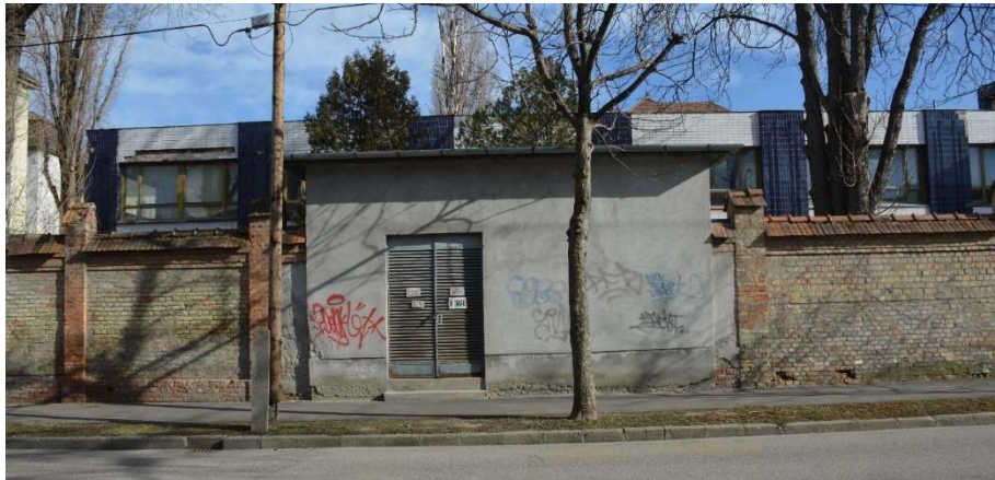
99. ábra Nyugati, Zrínyi utcai homlokzat
