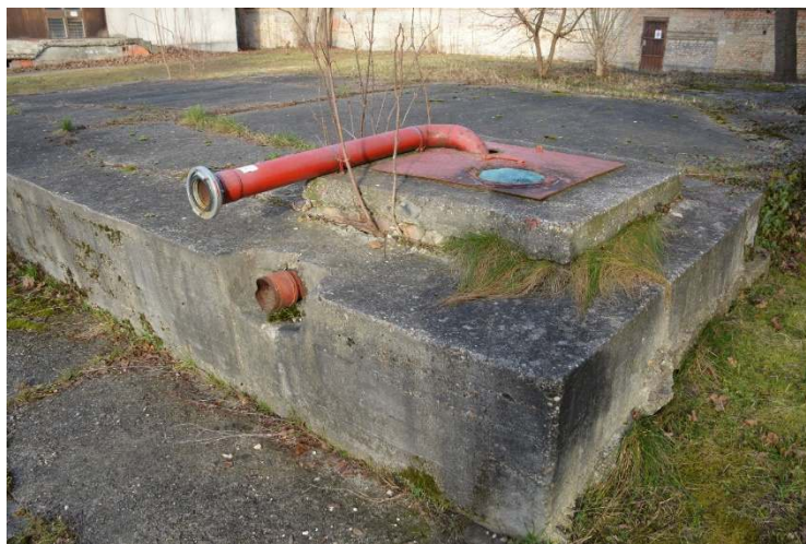
155. ábra Az aknafedlapból kiálló gépészeti cső
