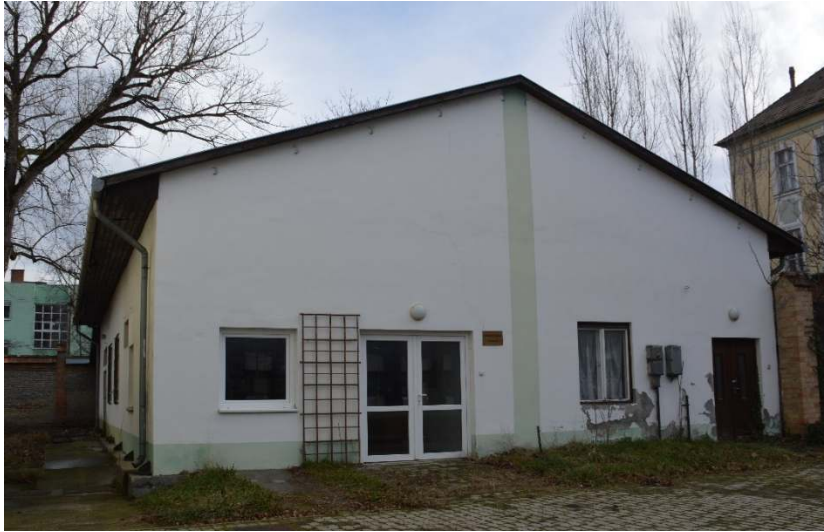
48. ábra Kórházudvar felőli, nyugati homlokzat
