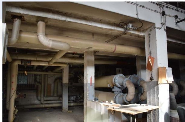
185. ábra A hőközpont tere (fszt északi oldal)
