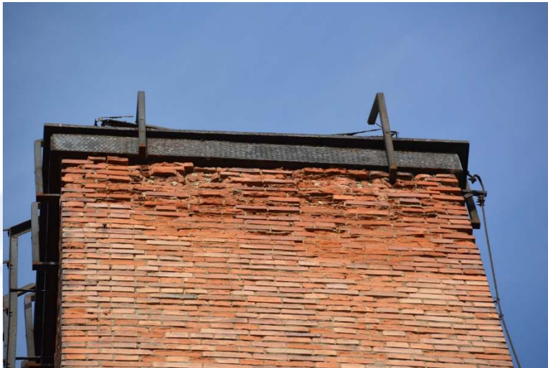
189. ábra A kémény fejezetének déli oldala a kifagyott téglákkal
