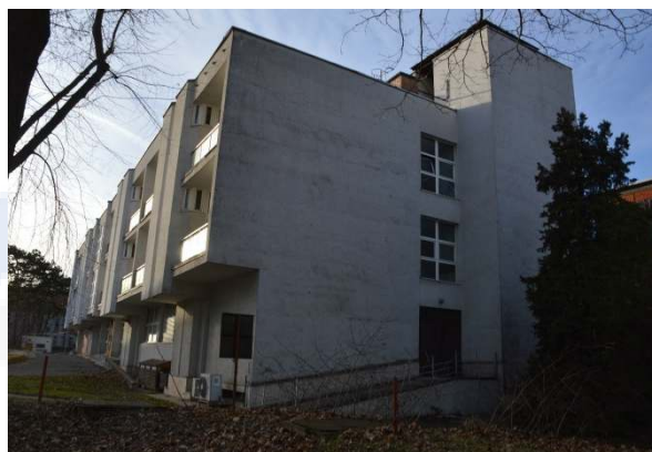
218. ábra Keleti homlokzat
