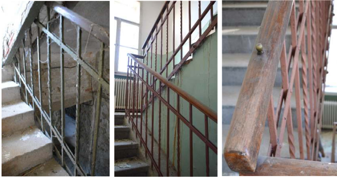
138. ábra Pincelépcső korlát részlete 139. ábra Emeletre vezető lépcsőkorlát részlete 140. ábra Rézgomb a fa kapaszkodón
