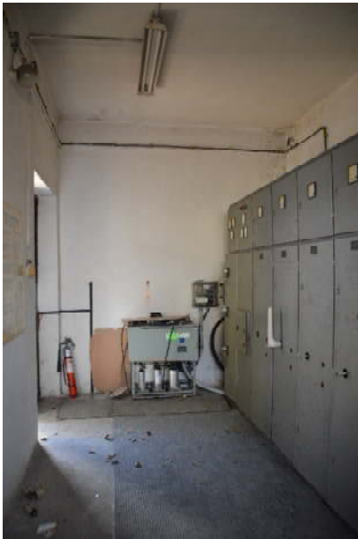
100. ábra A trafó keleti oldali terének részlete
