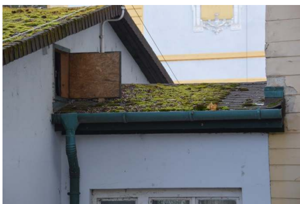
193. ábra Nyaktag északi homlokzata a padlásra vezető nyílással
