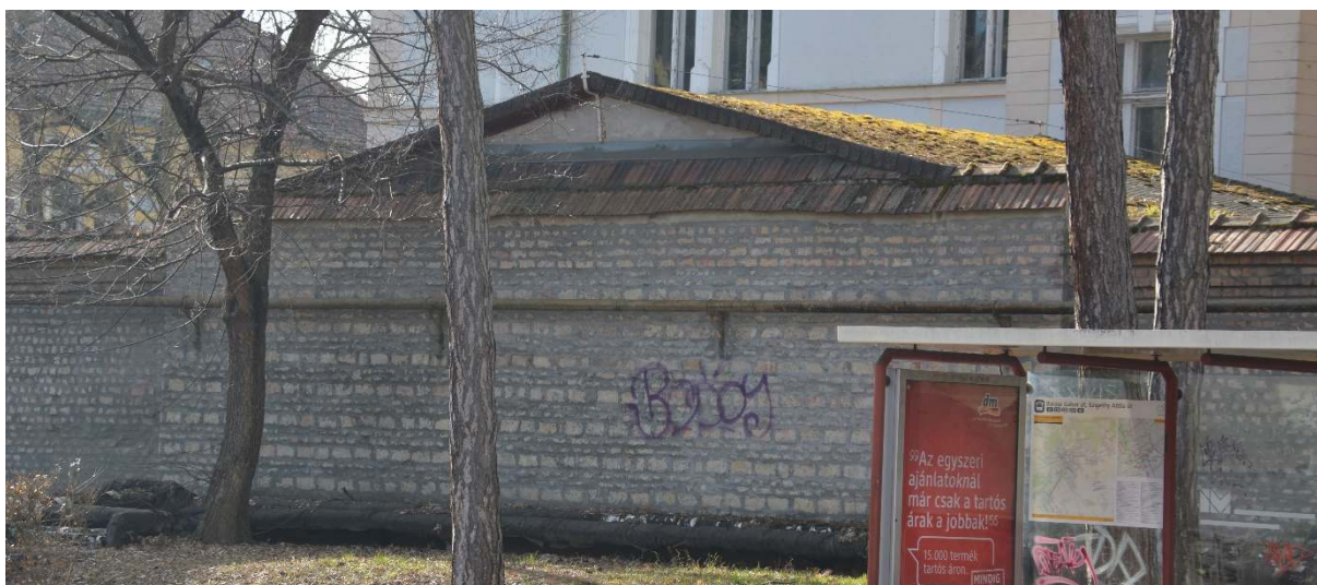
195. ábra Keleti oldali, Baross utcai homlokzat, újraépült kerítésfallal
