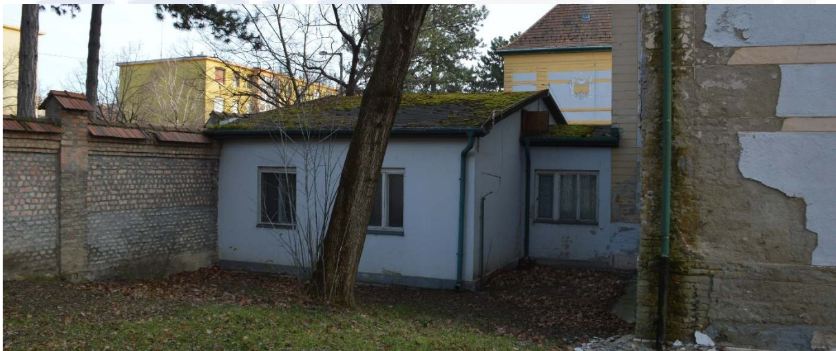
192. ábra A toldalék épületrész északi homlokzata
