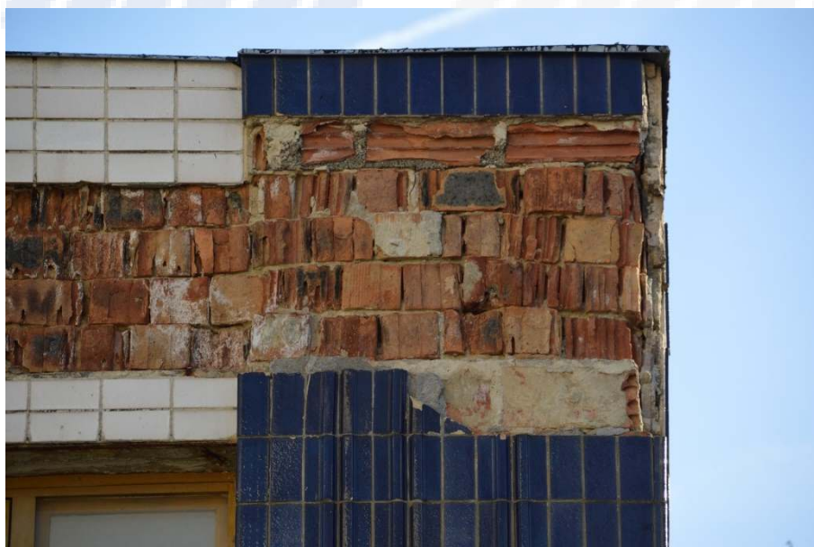
81. ábra Északi homlokzat burkolathiányos része
