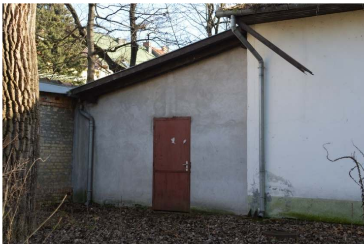
52. ábra Keleti toldalék északi homlokzata
