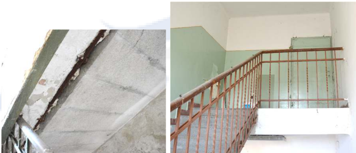
141. ábra Emeletre vezető műkö lépcsőfokok alsó síkja 142. ábra A padlásig vezető lépcsőkorláton is vannak réz gombok
