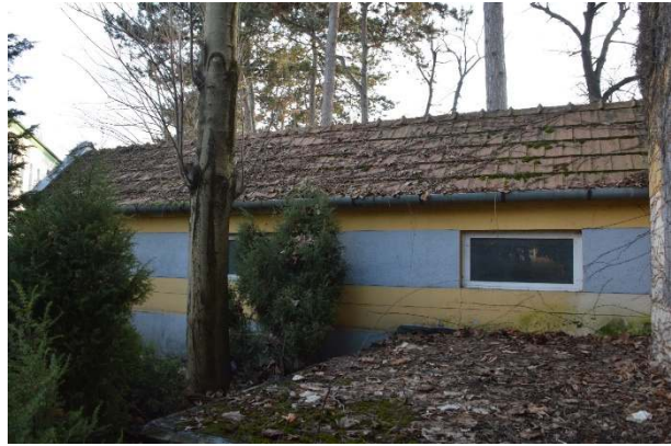
230. ábra ÉK-i homlokzat
