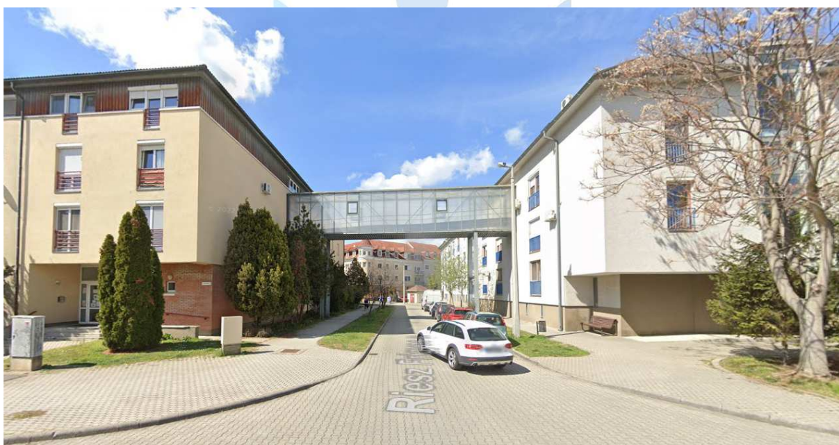
A Riesz Frigyes utca feletti meglévő átkötő híd
