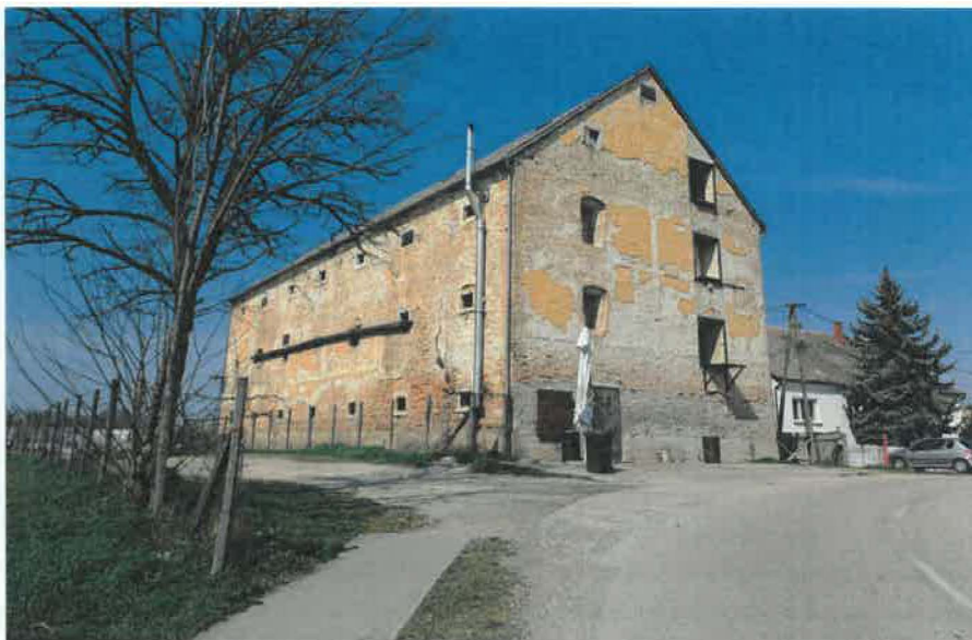
8. kép: A volt bencés majorság magtárépülete.
