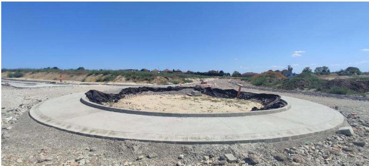
Épülő körforgalom az új gyűjtőúton
