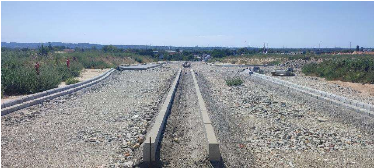
Panoráma út épülő felső szakasza
