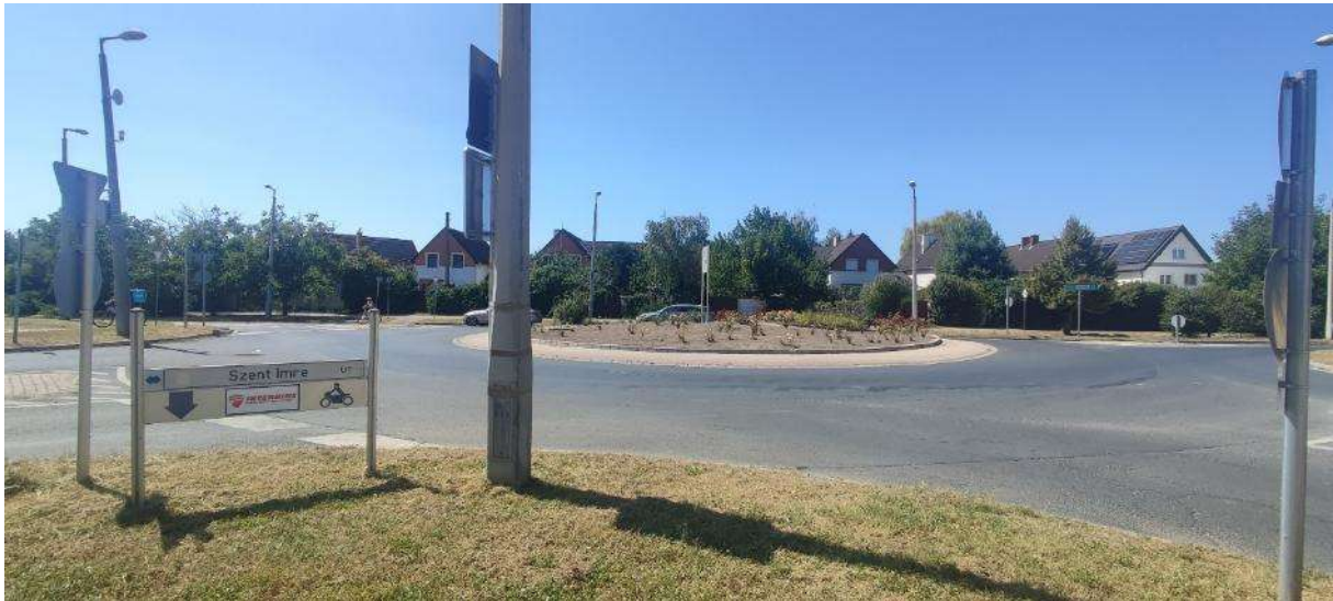
82. sz. főút – Szent Imre út – Kismegyeri út körforgalmi csomópontja; az új gyűjtőút miatt átépítése tervezett
