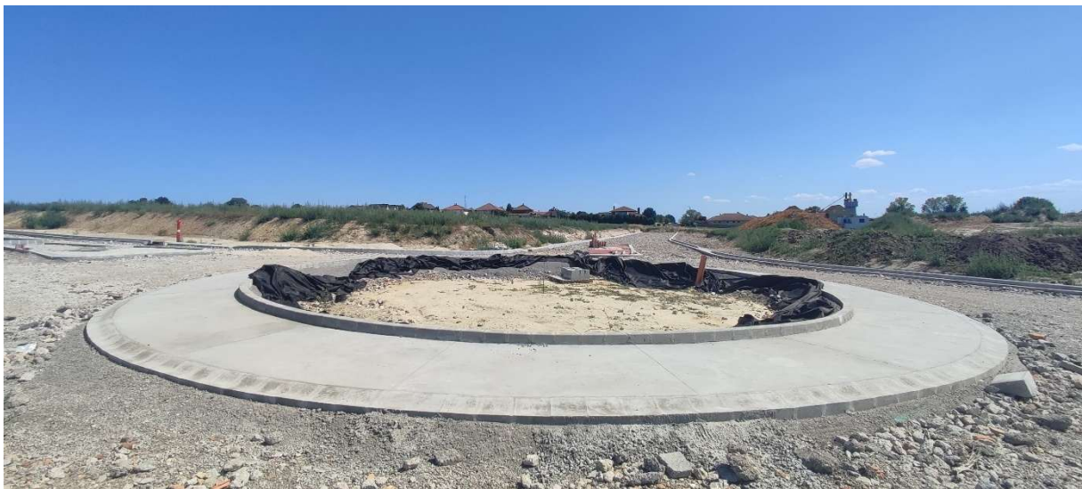
Épülő körforgalom az új gyűjtőtűton
