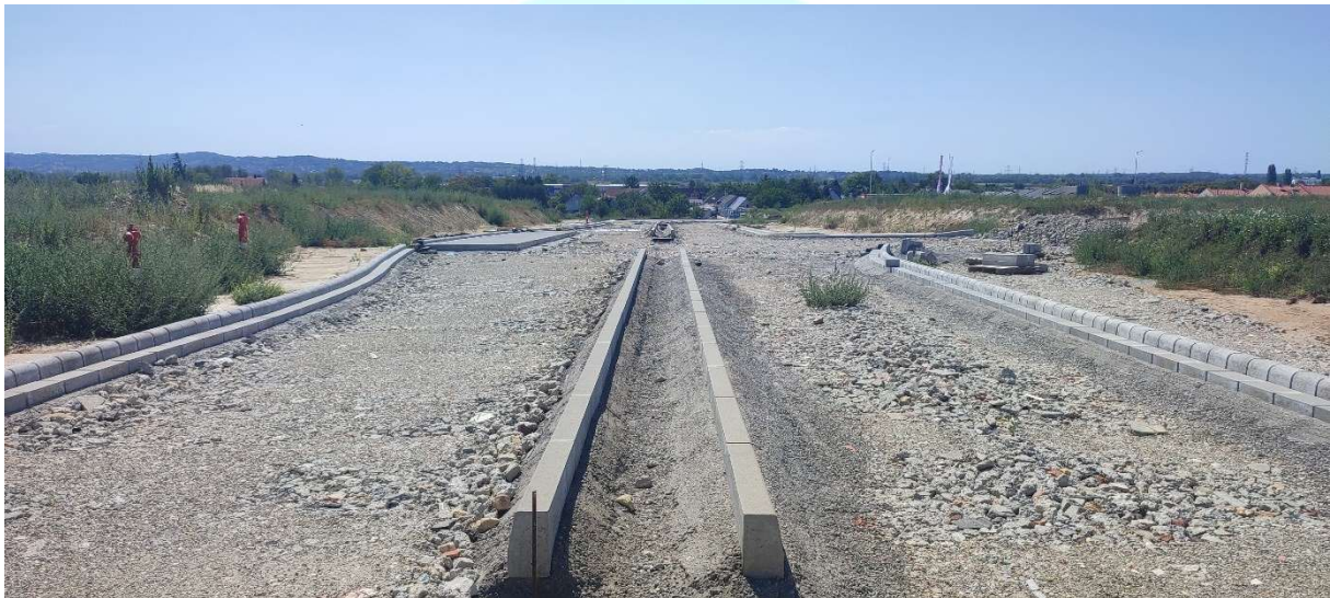
Panoráma út épülő felső szakasza
