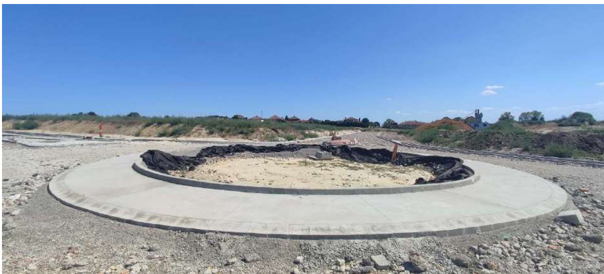
Épülő körforgalom az új gyűjtőúton
