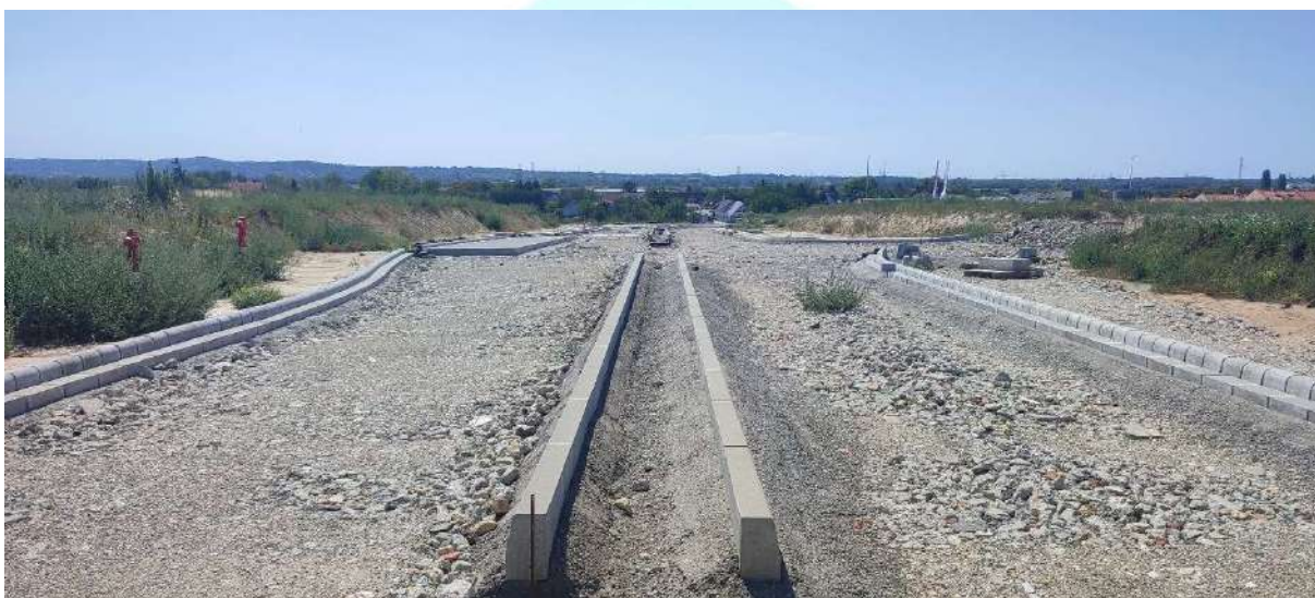
Panoráma út épülő felső szakasza
