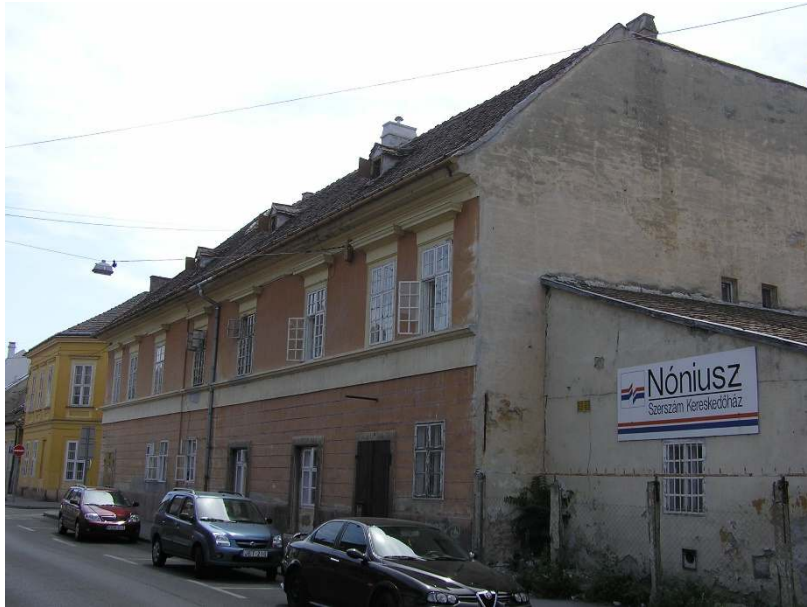
41. ábra 2007-es felvétel a Rákóczi u. 37. sz. épület Teleki utcai homlokzatáról, előtérben a Nóniusz Üzletház részlete 35
